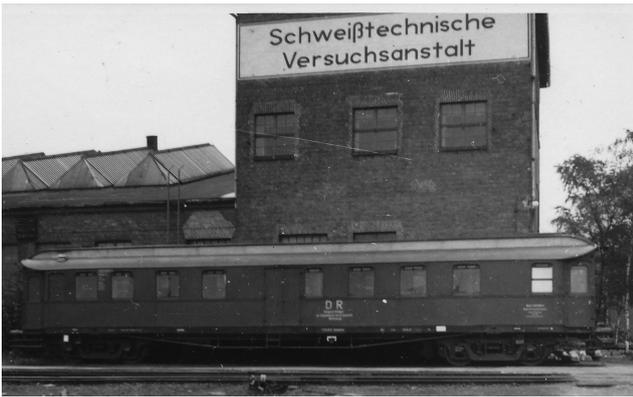
Bild 20: Röntgenprüfwagen der SVA Wittenberge nach 1950
