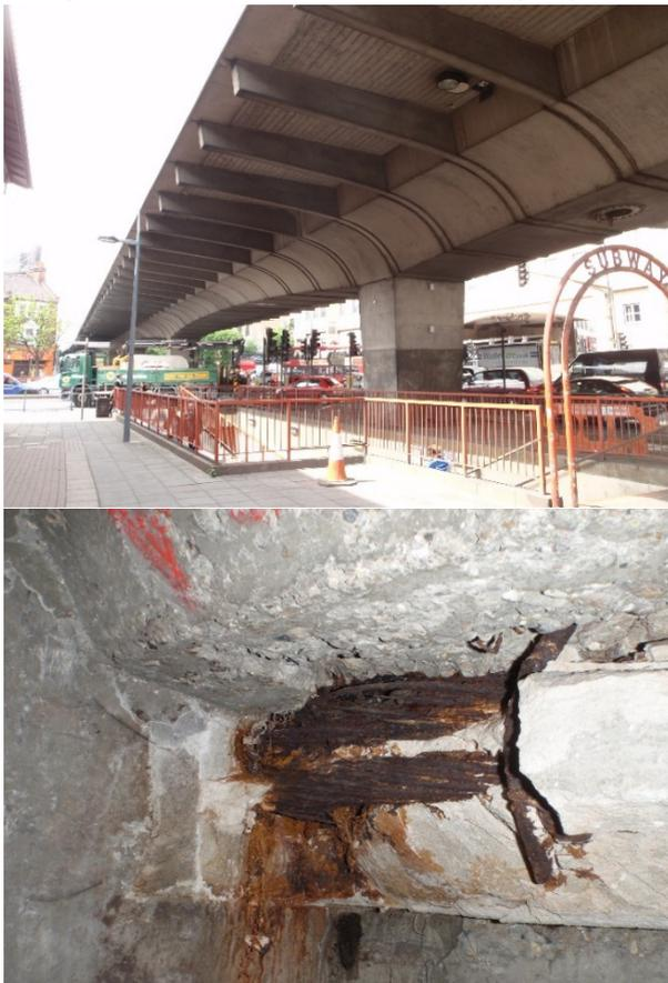
**Abb. 18: Ansicht der Hammersmith Flyover Brücke in London (Bild oben) mit Blick auf korrodierte Spanndrähte im Inneren der Brücke (Bild unten).**
