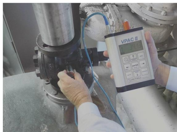
**Abb. 8: Prüfung eines Ventils auf innere Leckage mit dem VPAC II- System VPAC II.**
