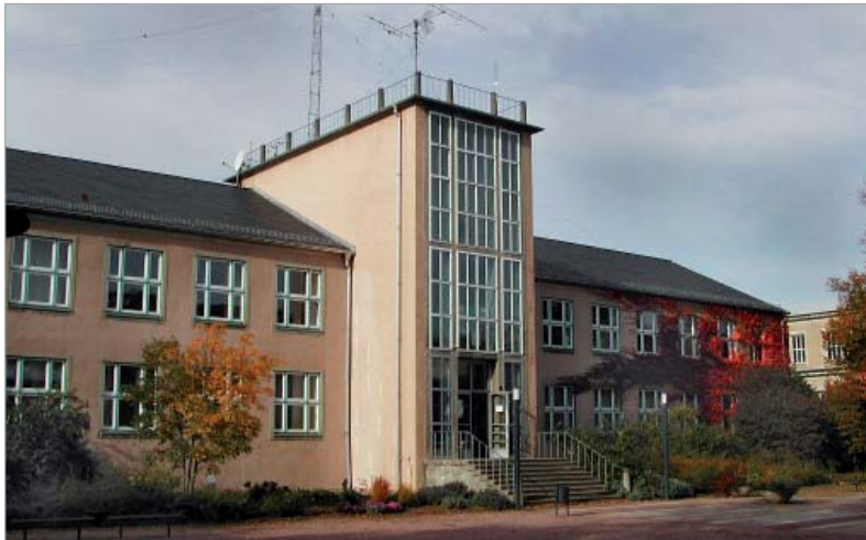
Barkhausenbau, Hauptgebäude der Fakultät Elektrotechnik und Informationstechnik
