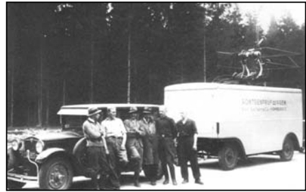
Bild 56: Röntgenwerk Seifert beim Prüfeinsatz an Autobahnbrücken
