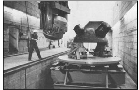
Bild 84: 31 MeV-BBC-Betatron bei Phoenix-Rheinrohr in Mülheim
