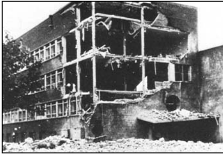
Bild 65: Das durch Bomben stark beschädigte Max-Planck-Institut in Düsseldorf
