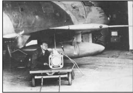
Bild 69: Hans Pelzer, MPI Düsseldorf, führt eine Durchstrahlungsprüfung an fliegendem Gerät durch
