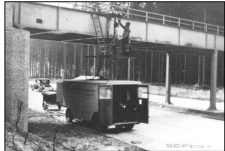
Bild 58: Ausrichten der Röhre auf gehobener Bühne
