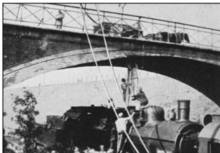
Bild 15: Lokomotive als Arbeitsbühne; der Röntgenfilm wird unter der Brücke befestigt
