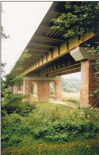
Abb. 34. Autobahn-Brücke „Mühlentrieb“, Rüdersdorf b. Berlin
