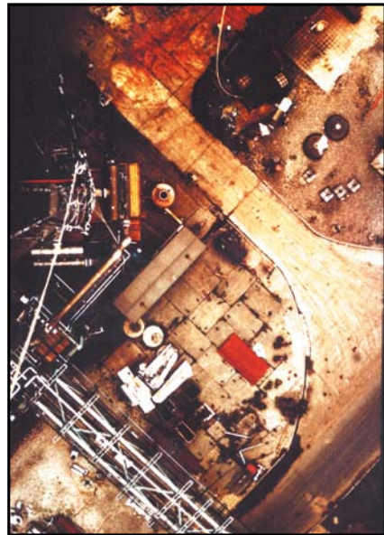
Schallemissionsprüfung an einer Reaktorkolonne. Anbringen von Aufnehmern in 40 m Höhe
