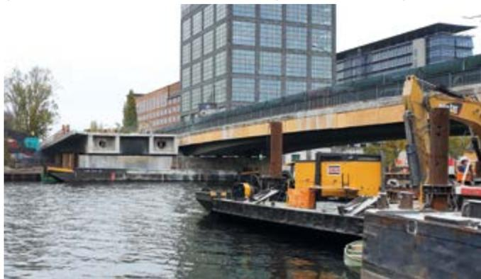
Bild 1: Blick auf den weiterhin unter Verkehr stehenden südwestlichen Überbau der Elsenbrücke. Links im Bild der südöstliche Überbau während des Rückbaus
