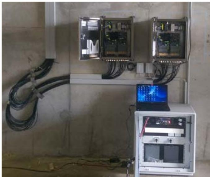
Bild 5: Ansicht auf das akustische Überwachungssystem
